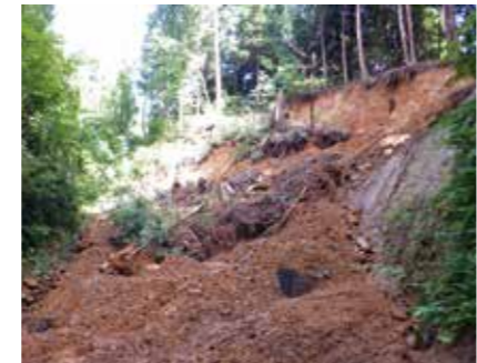
土砂崩れで通行不能となった農道
